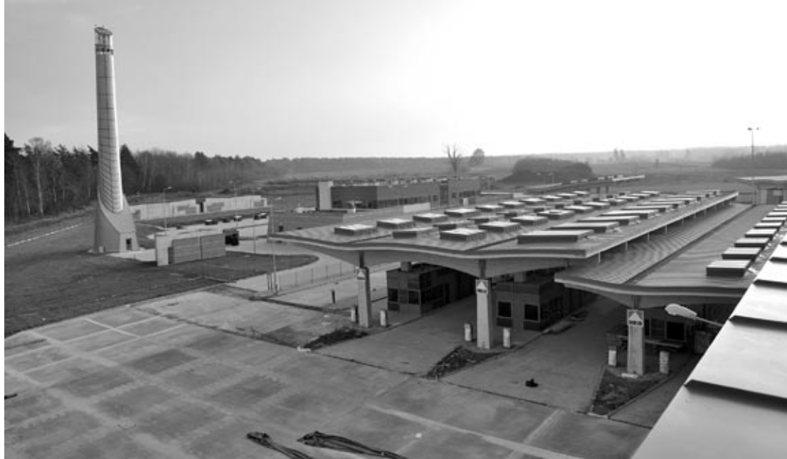
Na pierwszym planie stanowiska do odprawy paszportowej i celnej. W głębi, na prawo od wieży obserwacyjnej, budynek administracji przejścia (już wykończony wewnątrz)
