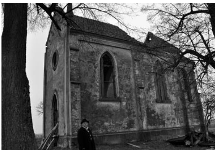
Hryhorij Ryszko, na tle niszczonego kościółka z XIX wieku, stojącego około 200 metrów od planowanej trasy z Hruszewa do przejścia granicznego w Budomierzu
