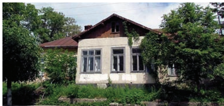
Budynek plebanii z pocz. XX wieku
