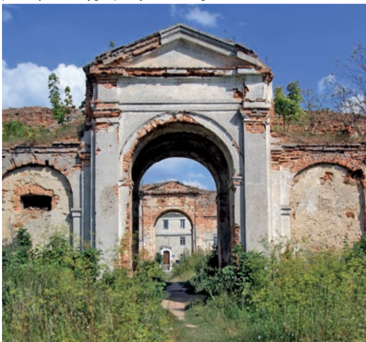
Główny wjazd do pałacu Sanguszków w Zasławiu
