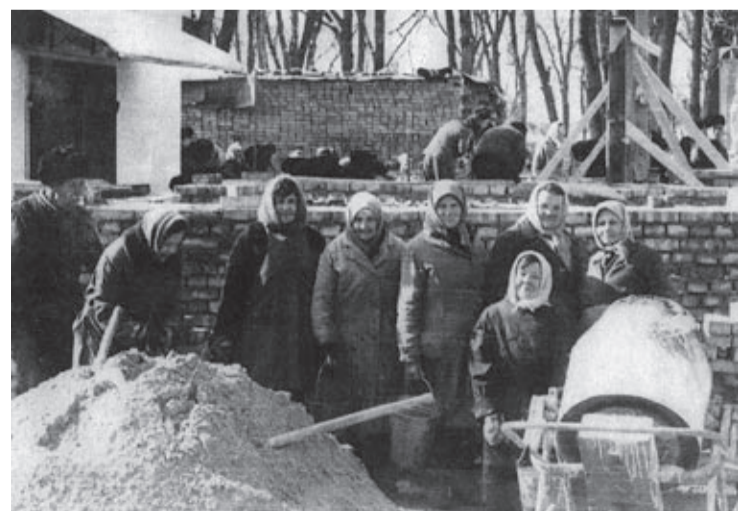
W Gródku były dwa kościoły: św. Anny i św. Stanisława zburzone w 1936 roku przez Sowieców. Pozostała tylko kapliczka cmentarna, wokół której mieszkańcy Gródka zbudowali kościół św. Stanisława. Na fotografii prace budowlane przy kościele w latach siedemdziesiątych
