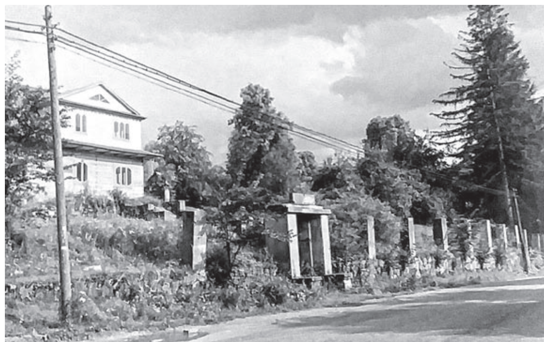
Fragment (pozostałości furty) ogrodzenia Domu Akademickiego w Mikuliczynie
