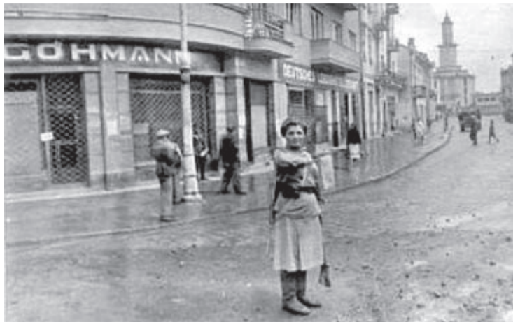
RADZIECKA KIEROWNICZKA RUCHU DROGOWEGO NA SKRZYŻOWANIU ULIC HALICKIEJ I BELWEDERSKIEJ
