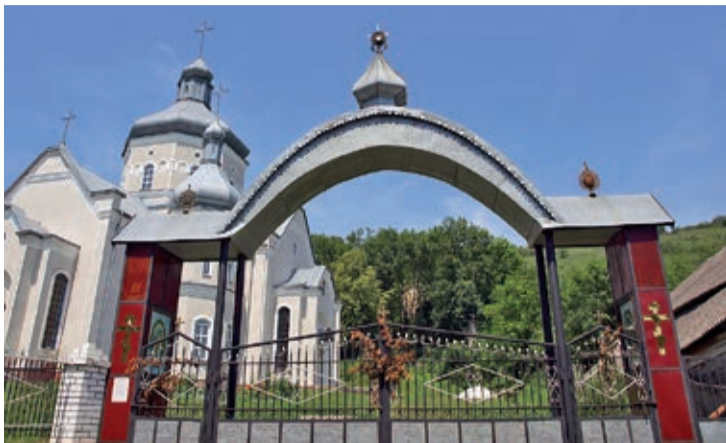
KUTYSZCZE. WIDOK NA BRAMĘ I CERKIEW. STAN 2012
