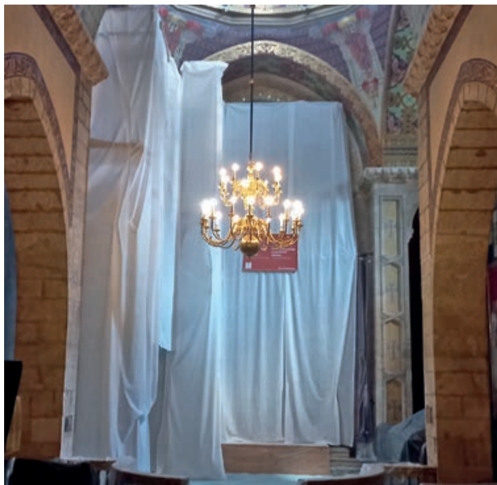
PRACE KONSERWATORSKIE W PREZBITERIUM KATEDRY ORMIAŃSKIEJ
